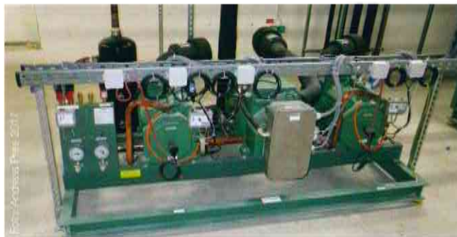
Die Verbundkälteanlage ist eine Alternative zu Einzelverdichtern.
